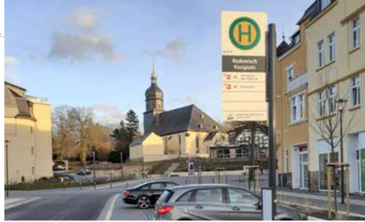
Mit der Neugestaltung des Rodewischer Postplatzes ist auch eine neue Bushaltestelle im Zentrum entstanden.
