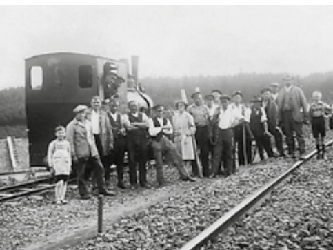
Gleisarbeiten um 1928 mit schmalspurigen Hilfsgleisen für Bau-Lokomotiven
