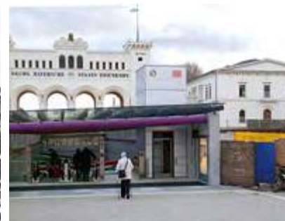
Zugang zum unterirdischen S-Bahn-Haltepunkt „Bayerischer Bahnhof“ in Leipzig
